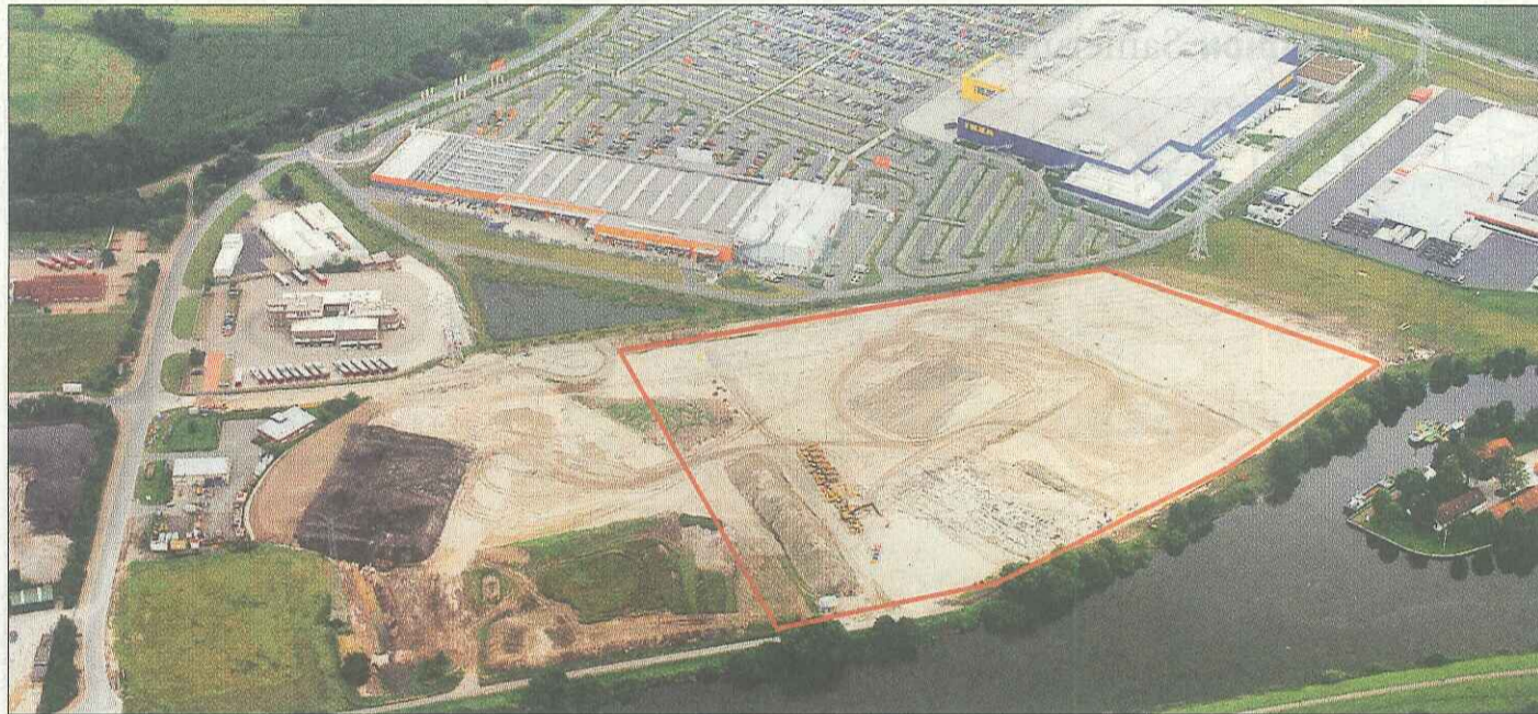
Der zurzeit größte Sandkasten der Stadt: das neue Baugrundstück des Fachgroßhandels Famo hinter Ikea und Küchen Meyer ist riesig, das knapp acht Meter hohe Gebäude darauf wird insgesamt etwa 200 Meter lang sein..
